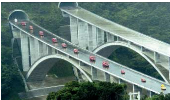
建設中の第2東名高速道路を走行する東京都隊（写真提供：静岡新聞社）
